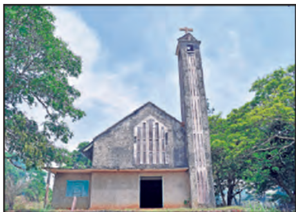
La façade principale de l'église (P.13)
