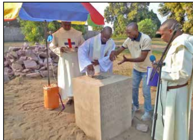
Le vicaire général procédant à la pose de la première pierre
