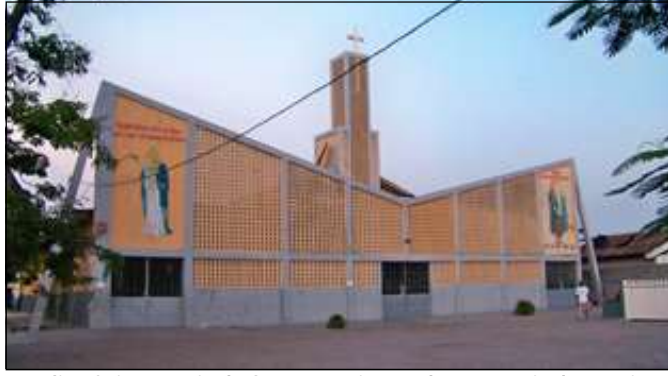
L'église Sainte-Marie de Ouenzé qui a perdu une partie de sa toiture.
