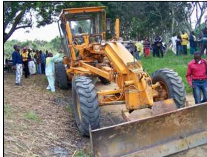
La niveleuse prête pour les travaux d'aménagement.
