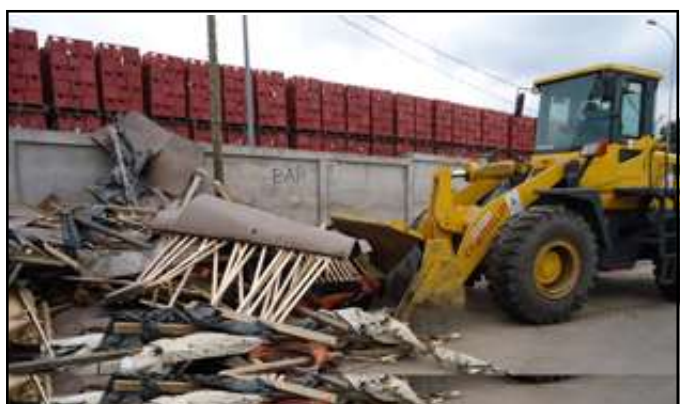
Un tracteur ramassant les débris des baraques démolies.
