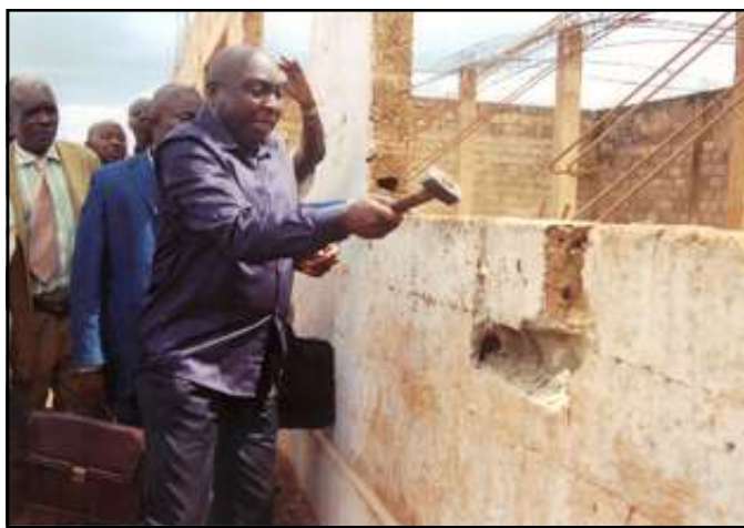
Paul Adam Dibouilou procédant à la démolition.
