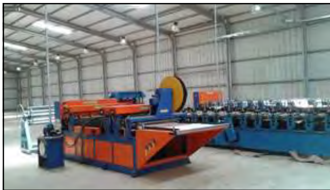
Les machines sont actuellement en train d'être installées.
