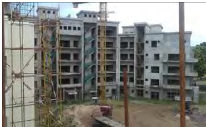
Un programme immobilier en chantier à Brazzaville.
