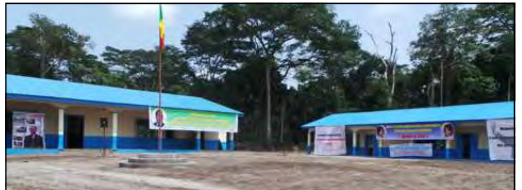
Les deux principaux bâtiments de l'école Ghislain Aristide Okemba Dzonga d'Ondebé.
