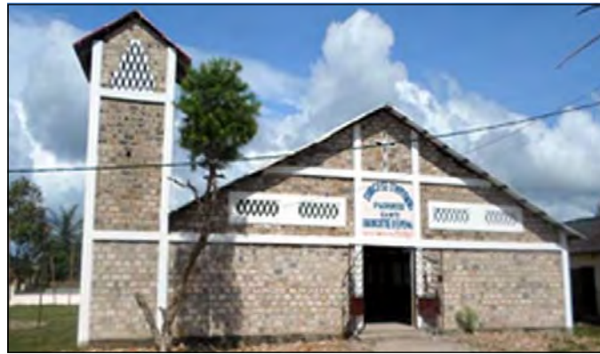
La façade avant de l'église Sainte Brigitte d'Epena réhabilitée.
