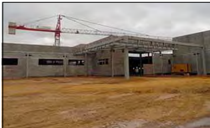
Vue de l'hôpital général en construction.
