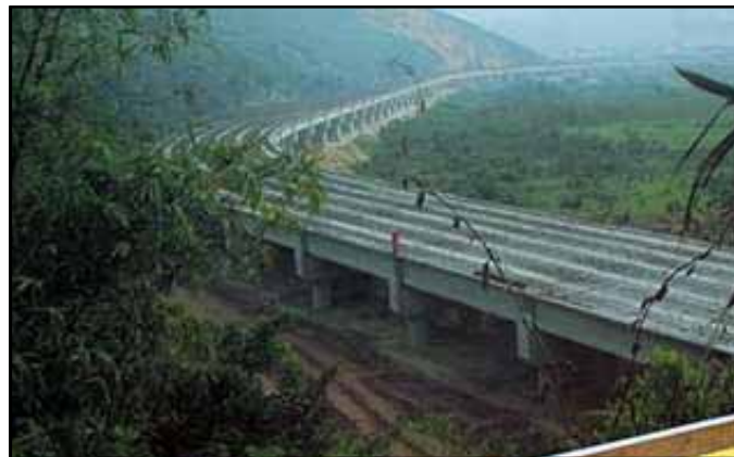
Le viaduc est déjà là.
