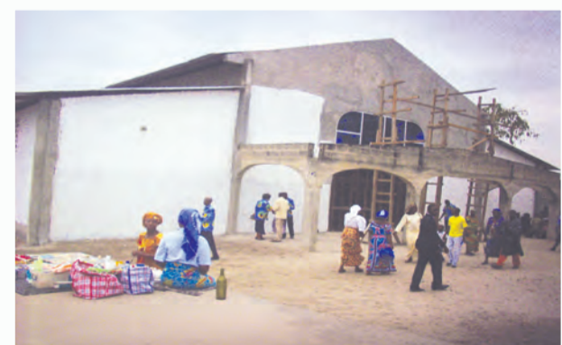
L'église Saint Augustin de la Tsiémé lors des travaux d'agrandissement.
