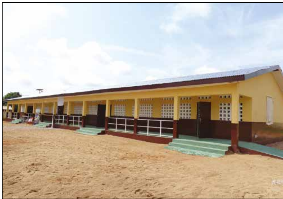
Le nouveau bâtiment, don de la société Total.
