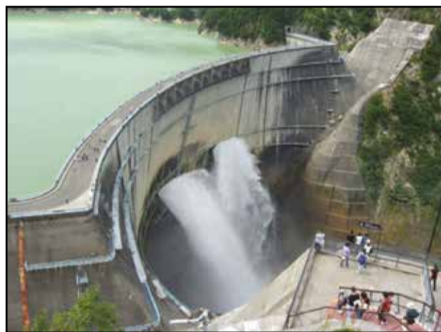
Le nouveau barrage.
