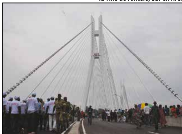
Vue d'une partie du viaduc.
