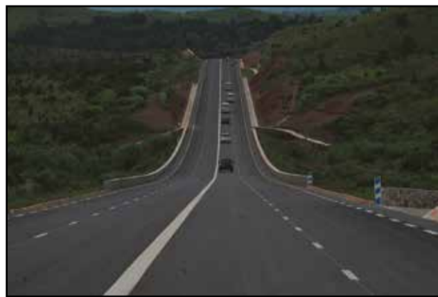
Un tronçon de la route.
