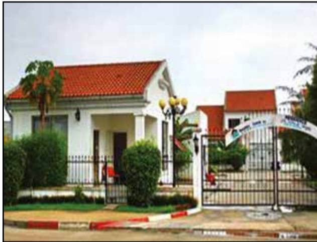
Les villas construites à Pointe-Noire.
