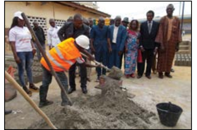
Maurice Mavoungou posant l'acte symbolique de lancement des travaux.
