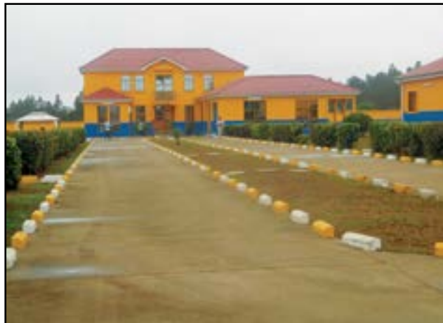
Une vue extérieure du palais royal.
