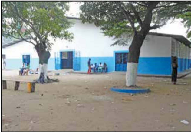
La façade principale de l'église Ndonga Marie de Mfilou.
