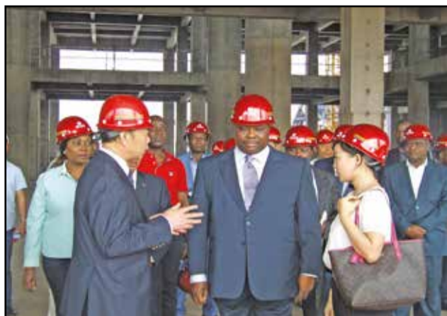
Pendant la visite des chantiers.
