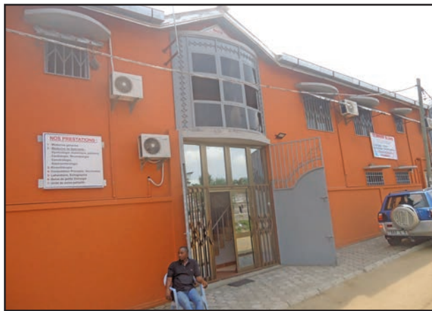
La façade principale de la Maison de santé et d'accompagnement, à Moundali
