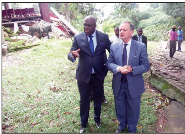
Dieudonné Moyongo et Bertrand Cochery visitant le bâtiment endommagé
