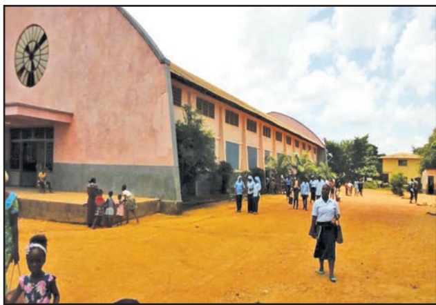
La façade latérale gauche de la cathédrale Saint Louis de Nkayi
