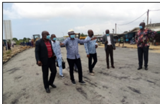
Les conseillers Municipaux sur le chantier de l'avenue Marien Ngouabi
