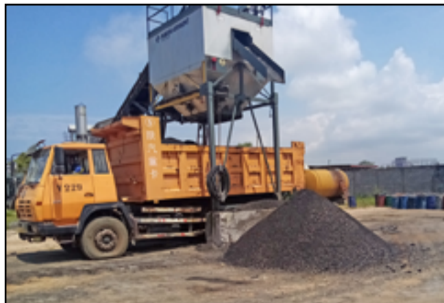
station de chargement du bitume
