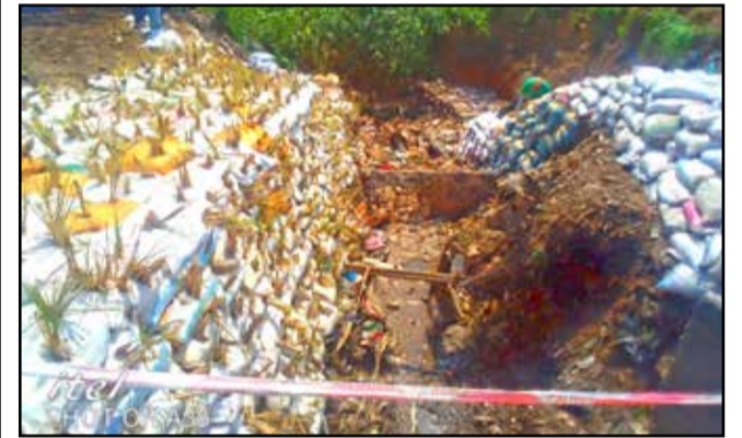
Vue d'une technique de lutte contre les érosions
