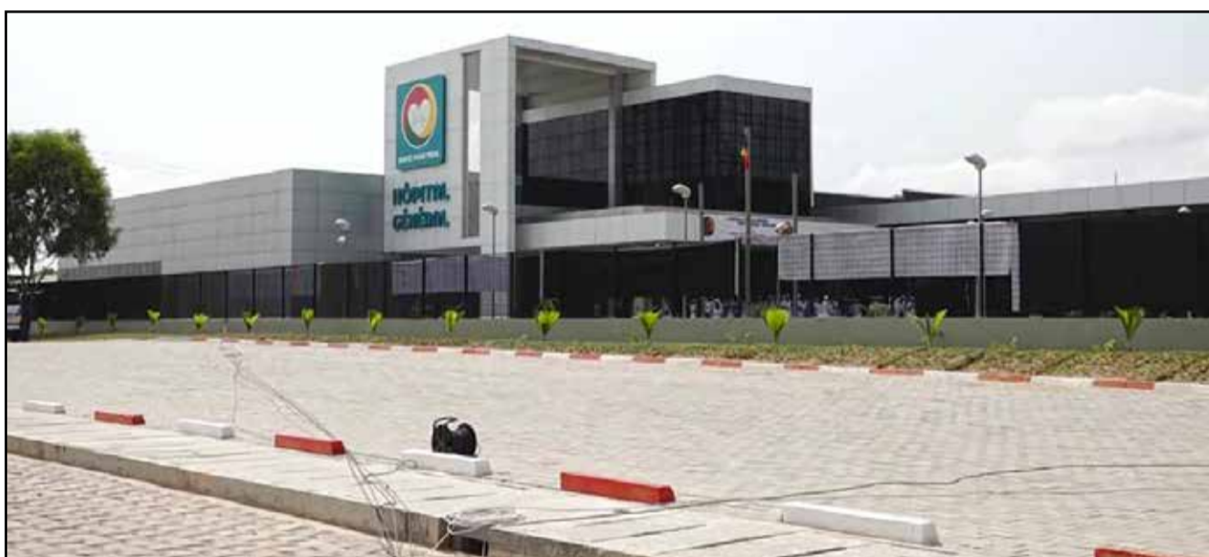
Une vue extérieure du nouvel établissement sanitaire (P.3)
