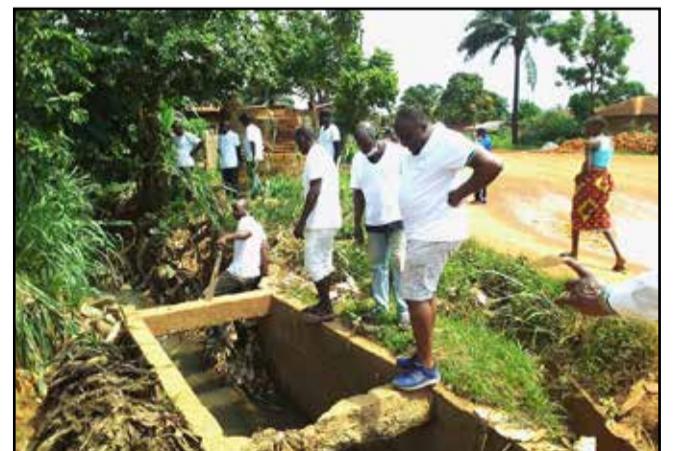
Le collecteur de Mellet avant son déblayage
