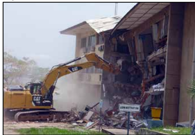
La démolition de l'un des bâtiments
