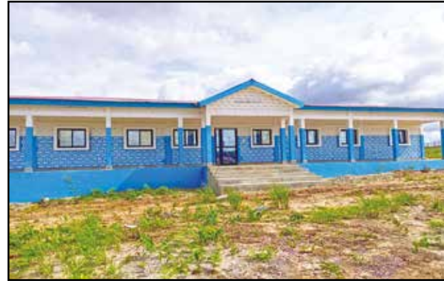
Le bâtiment principal du CSI de Loumo.
