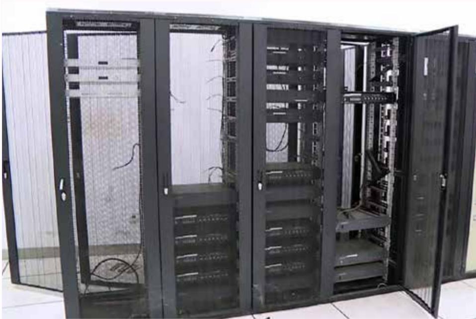
Ce qui reste d'une salle pillée (P.23)
