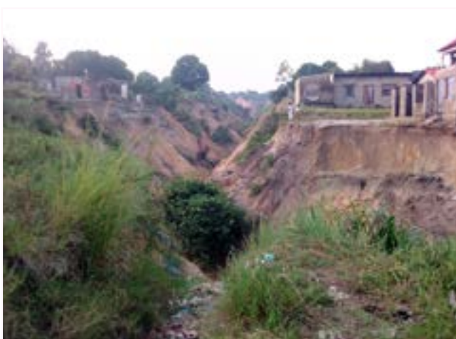
Maisons et routes, rien ne résiste au glissement de terrains
