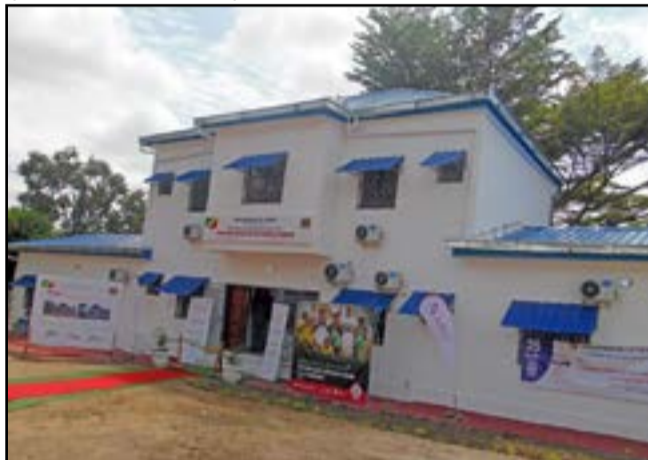
Le bâtiment abritant le Programme national de lutte contre le paludisme.
