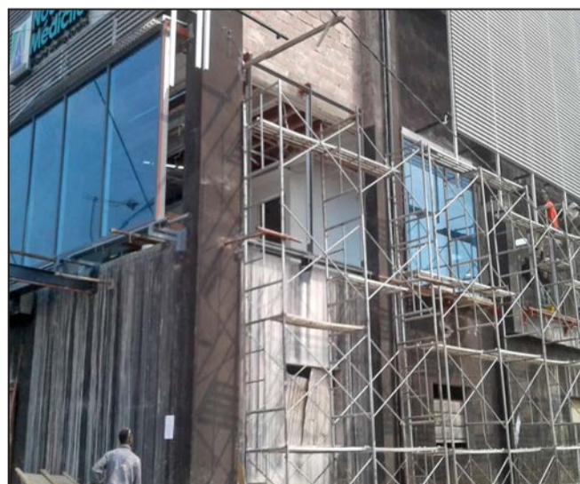
Vue des travaux de construction de la clinique Nouvelle vie medicite
