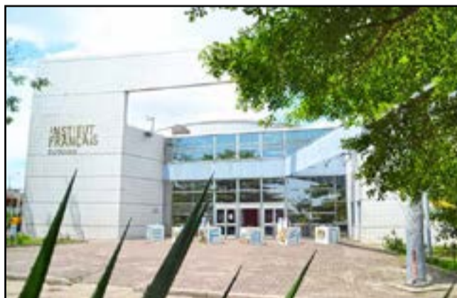
La façade principale de l'Institut Français du Congo à Brazzaville
