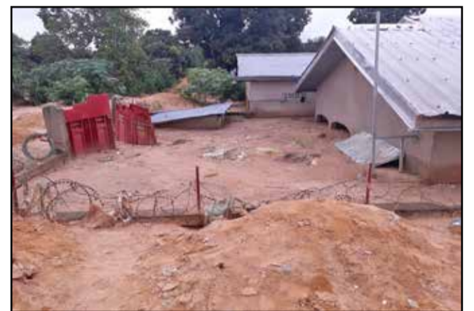
Une maison engloutie au quartier Ngambio, à Mfilou
