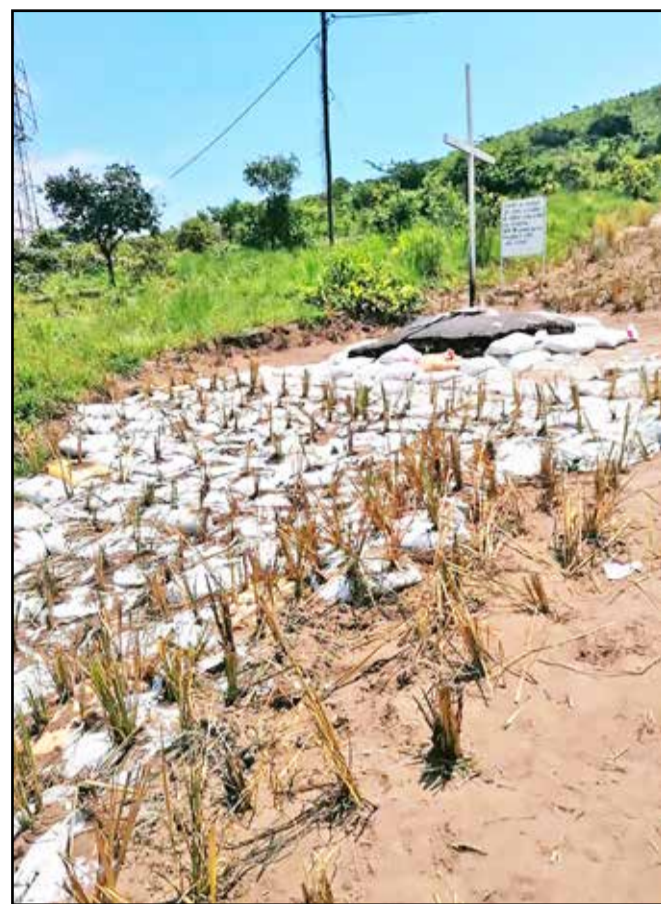
Les sacs de protection contre les érosions
