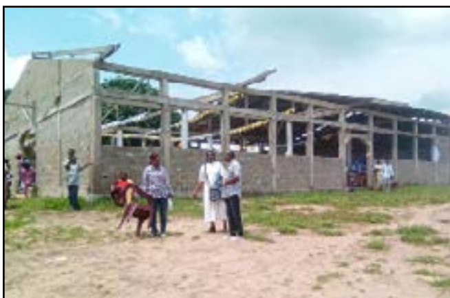
L'église de Ngampoko en construction nécessite un soutien
