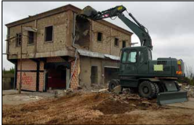
La démolition des bâtiments
