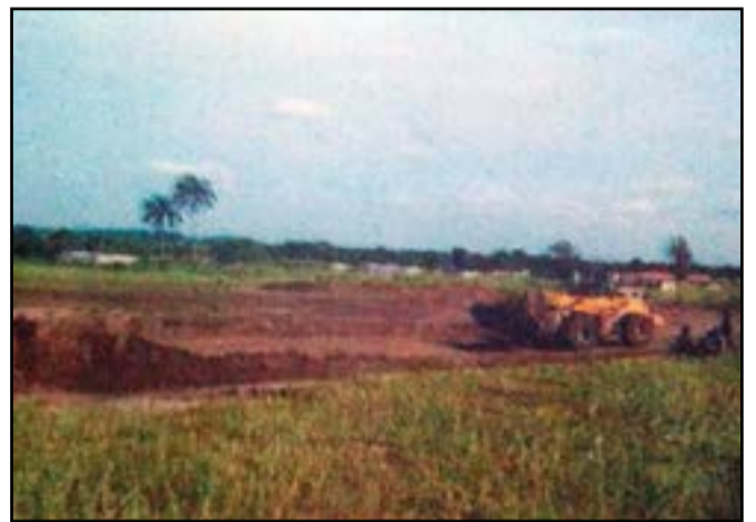
Le centre Gothia de Mfilou pendant les travaux de nivelage
