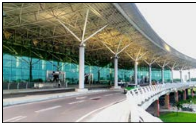
Vue partielle de la façade principale de l'aéroport international Maya-Maya
