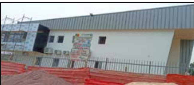
Le dépôt pharmaceutique en construction
