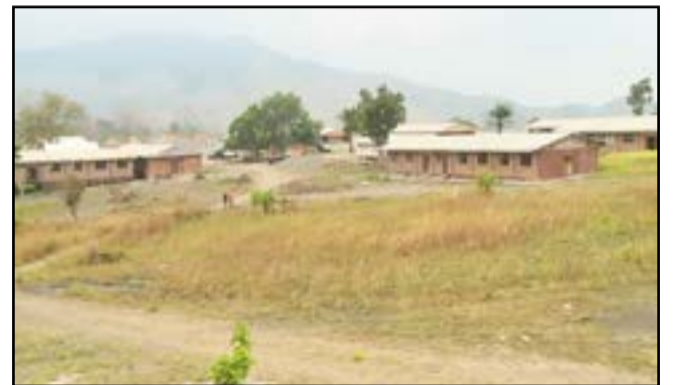
Une vue des bâtiments déjà sortis de terre
