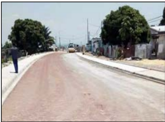
Une route en travaux
