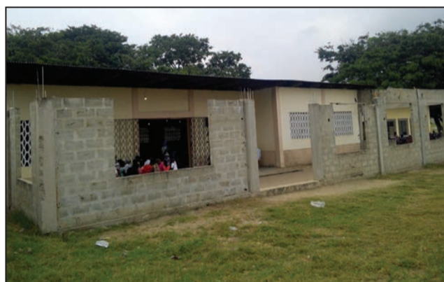
La façade de l'église en plein agrandissement
