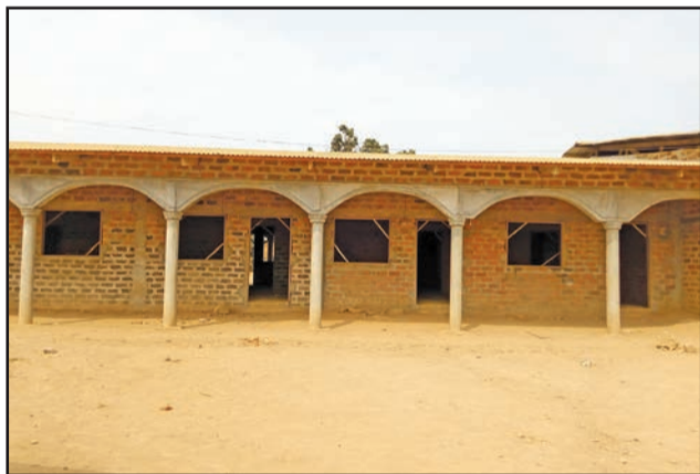
Le presbytère et la chapelle Saint-Jean-Paul II en construction
