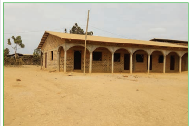
Le presbytère en construction et la chapelle provisoire de St Jean Paul II de Nkayi (P.8)
