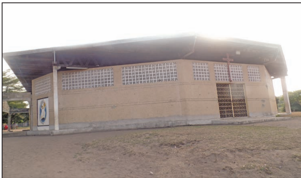
Une vue extérieure de l'église
