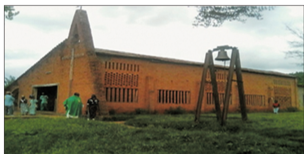
La façade latérale de l'église Saint-Joseph de Mokeko (P.10)
