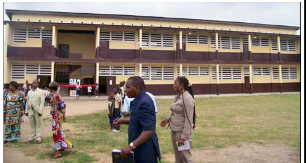
L'école primaire de Mbama réhabilitée.
