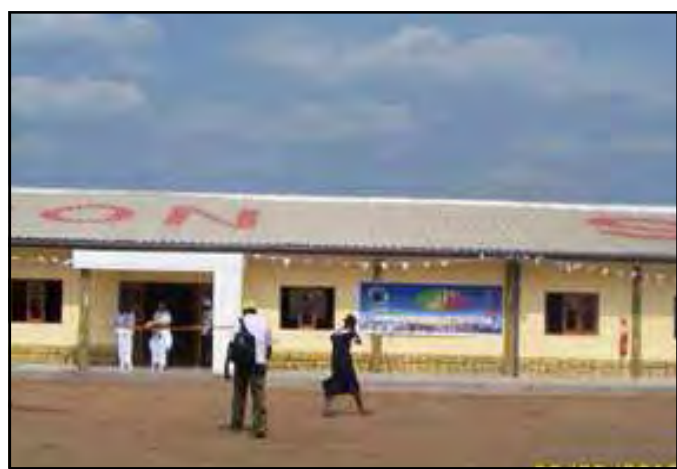
Un module des bâtiments réhabilités.
