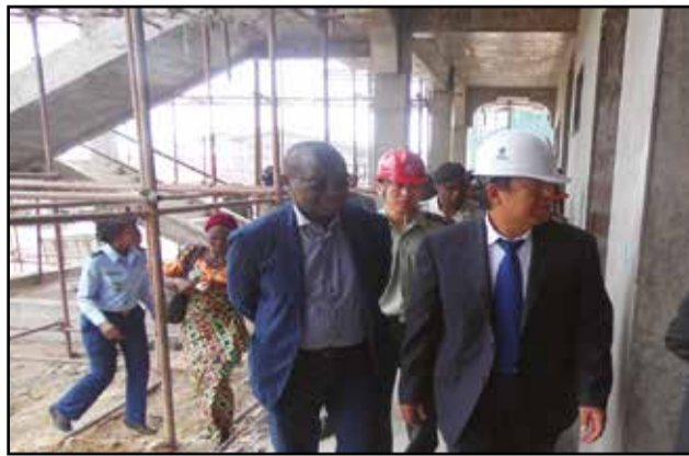
Charles Richard Mondjo et Xia Huang pendant la visite du chantier.
