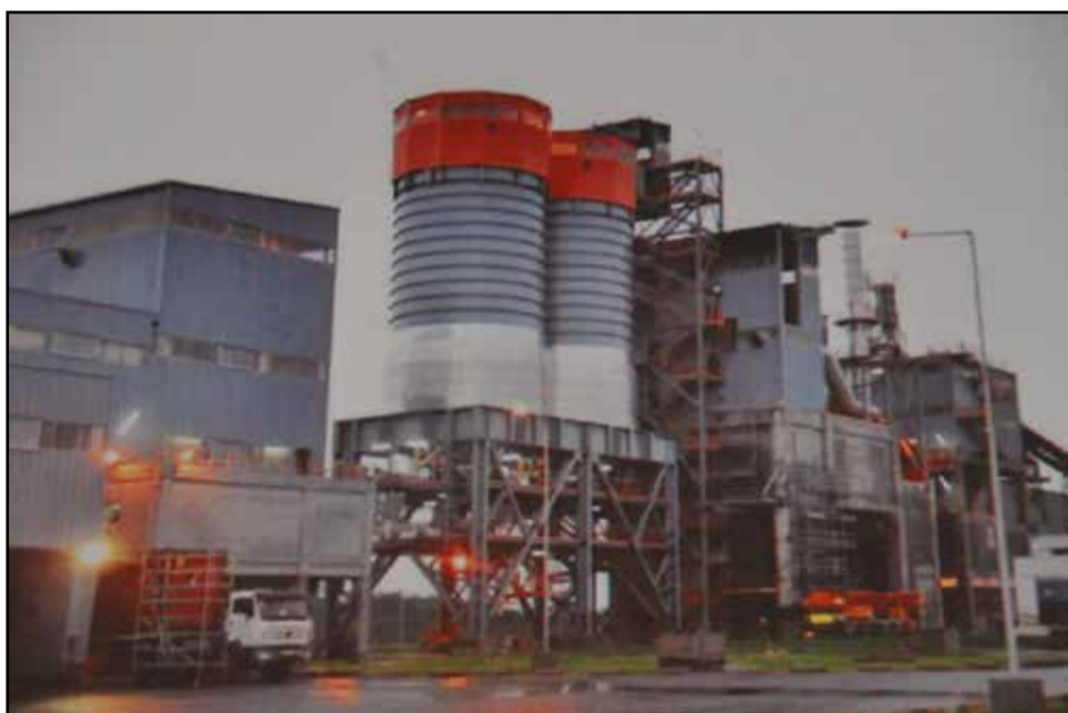
Une vue de la cimenterie de Makola.
