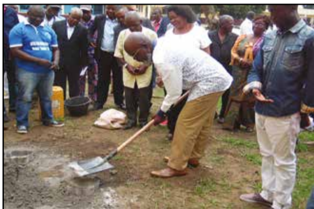
François Loussakou lançant les travaux.
