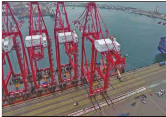
Le déchargement des portiques.
