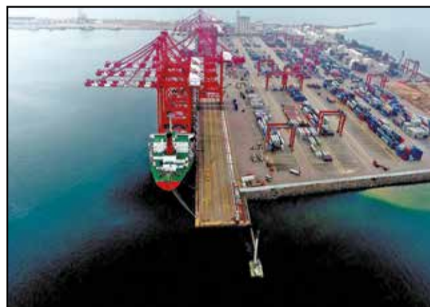
Accostage du navire transportant les portiques.
