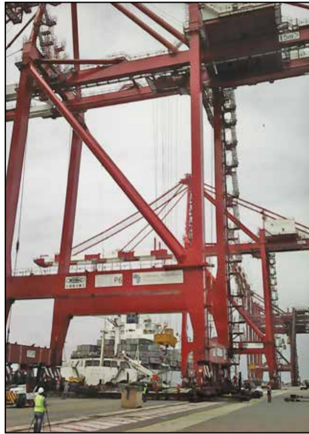
Les portiques au Port autonome de Pointe-Noire
